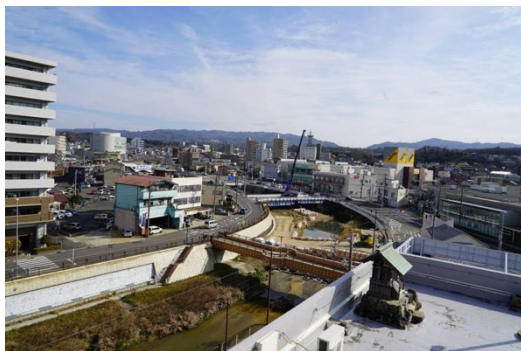
（図14）修正前 屋上から撮影・現在
